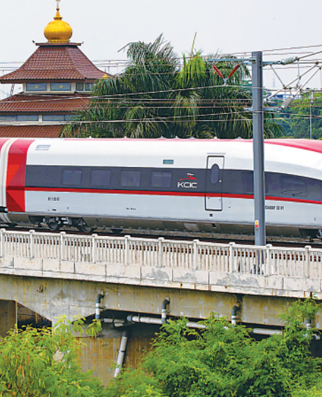
▲ 11 月 9 日,在印度尼西亚西爪哇省万隆市,一列高铁动车组正在雅万高铁试验段进行热滑试验。
